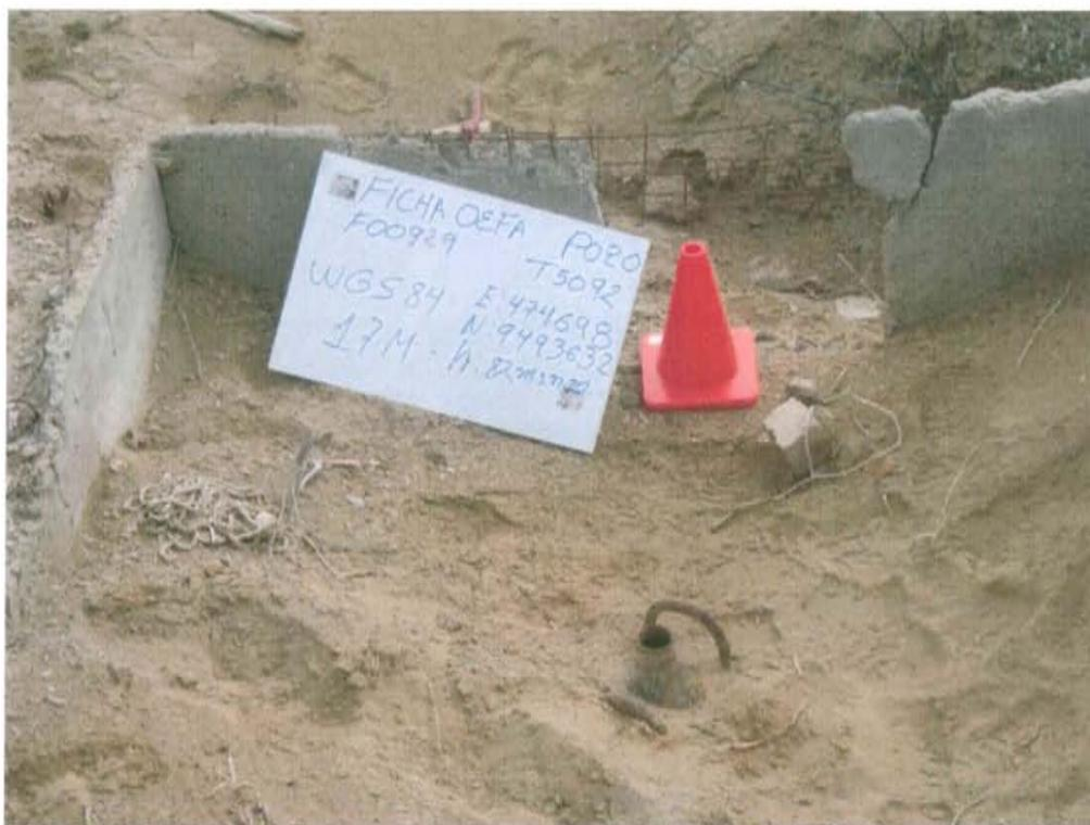
**Fotografía N° 1.** Pozo abandonado T5092 con una reducción tipo botella expuesta y cantina desgastada, el cono representa el Norte, tomando de referencia el pozo.
