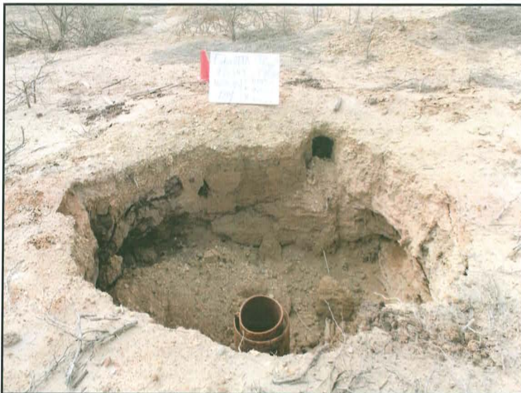
Fotografía N° 1. Pozo T 2083 presenta doble casing de 14 y 11 plg, a una altura de 0,5 m desde la base del hoyo circular de 2,5 m de diámetro y 1,2 m de profundidad.
