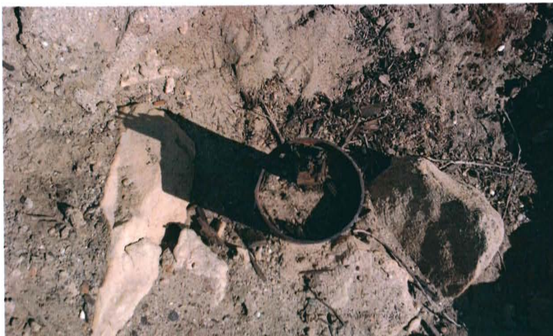
Fotografía N° 3. Vista del pozo incativo, cuya entrada se encuentra bloqueado por la presencia de arena y restos orgánicos.
