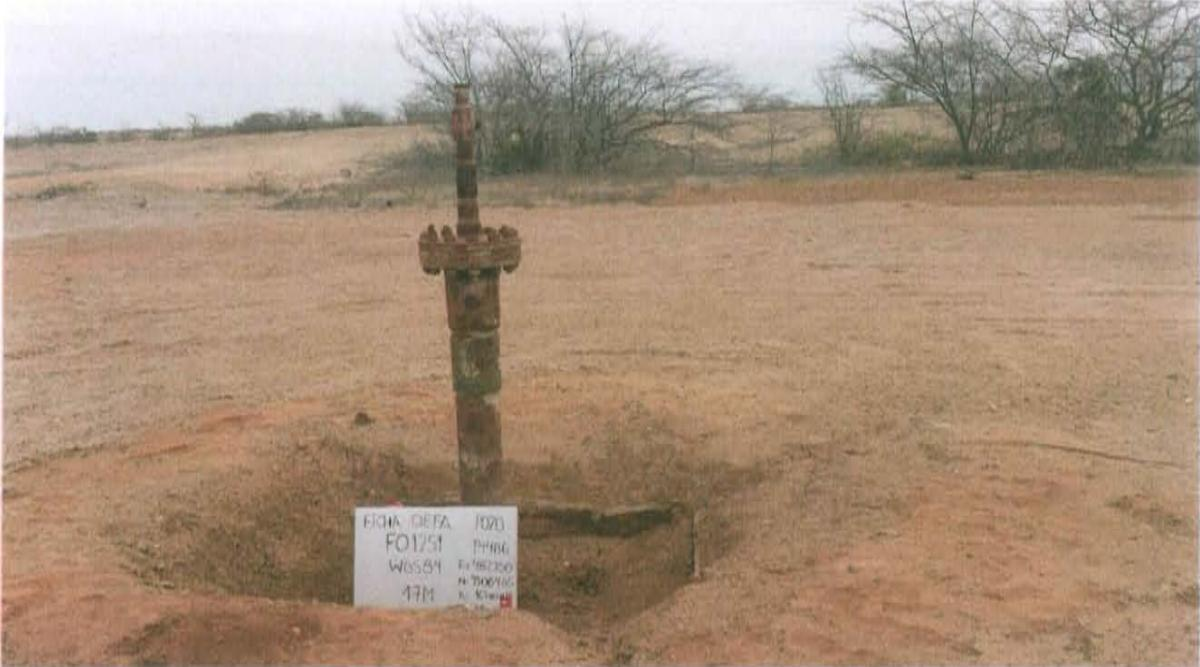
Fotografía N° 1. Se observa el casing con brida, en estado de corrosión en el interior de un hoyo.
