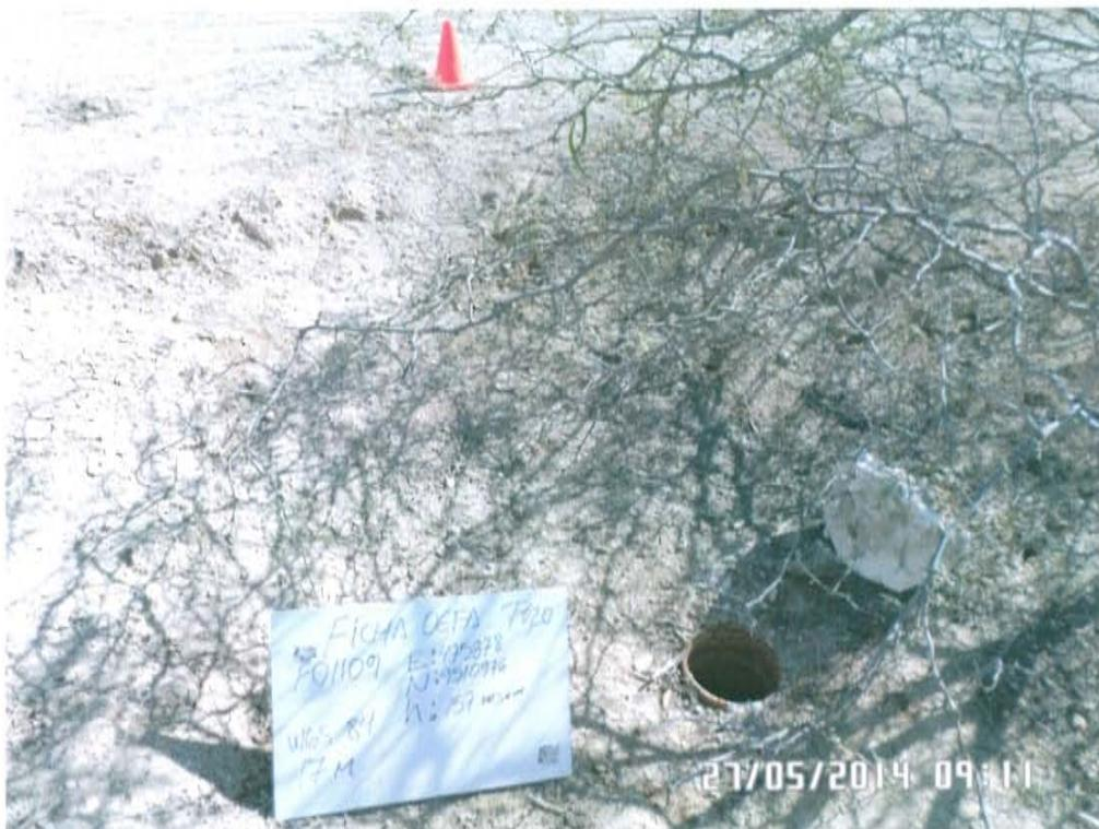
**Fotografía N° 1.** Vista del pozo abandonado con código de ficha OEFA F01109, se observa el casing expuesto y a nivel de la superficie del suelo.
