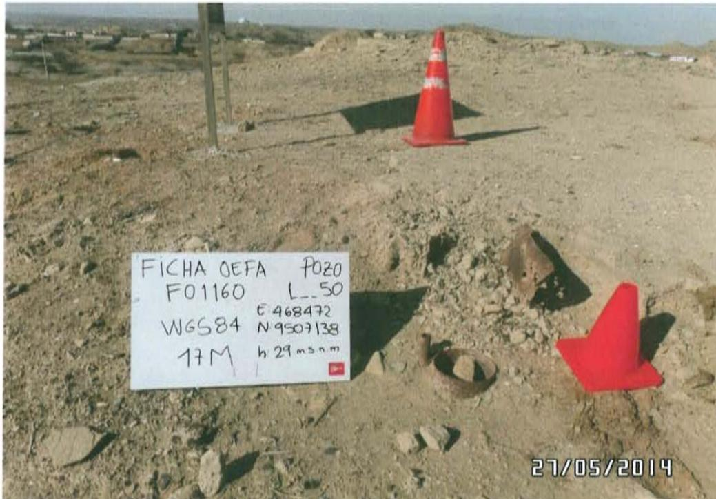
Fotografía N° 1. Pozo con código Ficha OEFA F01160 y con código PERUPETRO L\_50, se observa el casing corroído, tapado por piedras y tierra.
