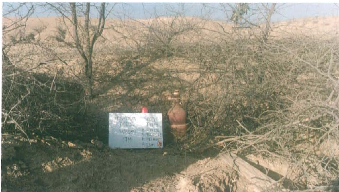
Fotografía N° 1. Se observa casing unido a una reducción tipo "botella" con válvula en la parte superior.
