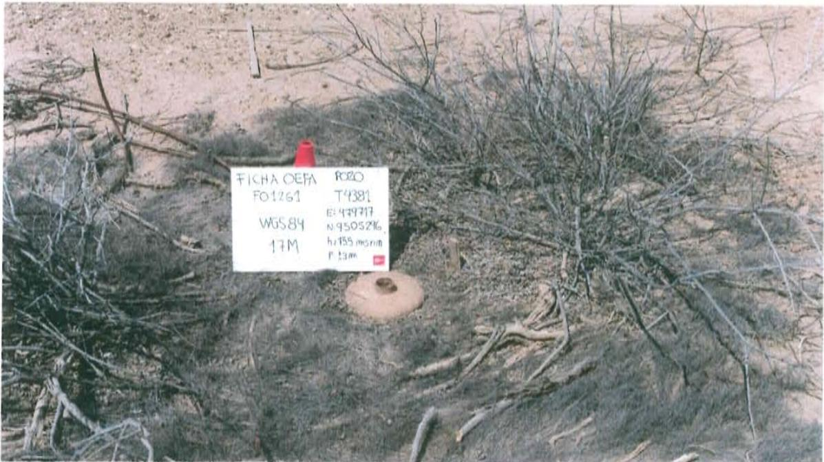
Fotografía N° 1. Se Observa Pozo expuesto al medio ambiente, que no presenta cabezal ni elemento de cierre en superficie (válvulas, llaves entre otros) y se encuentra rodeado por vegetación autóctona.
