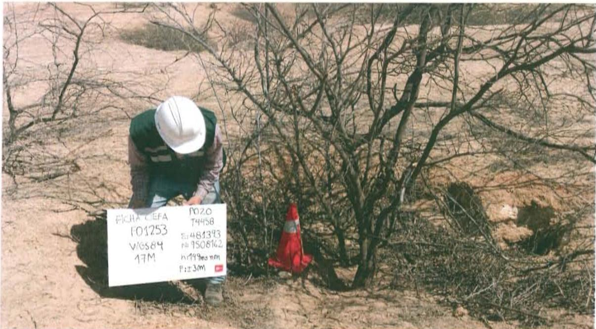
Fotografía N° 2. Pozo inactivo que presenta tubería de reducción de 2", no presenta terraplén habilitado.
