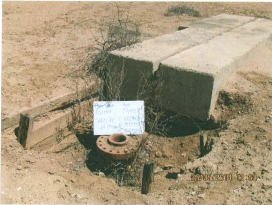
Fotografía N° 1. Pozo inactivo con código PERUPETRO T4948, presenta casing con brida se observa adyacente a la cantina se tiene una viga monolítica (base de la unidad de bombeo).
