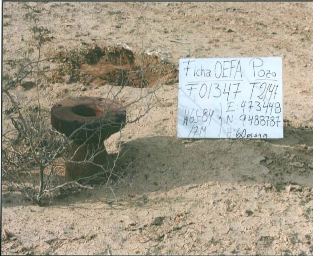
Fotografía N° 1. Pozo T 2147 presenta casing de 8 plg de diámetro con una brida de 16 plg y 0,3 m de altura desde la superficie del suelo.
