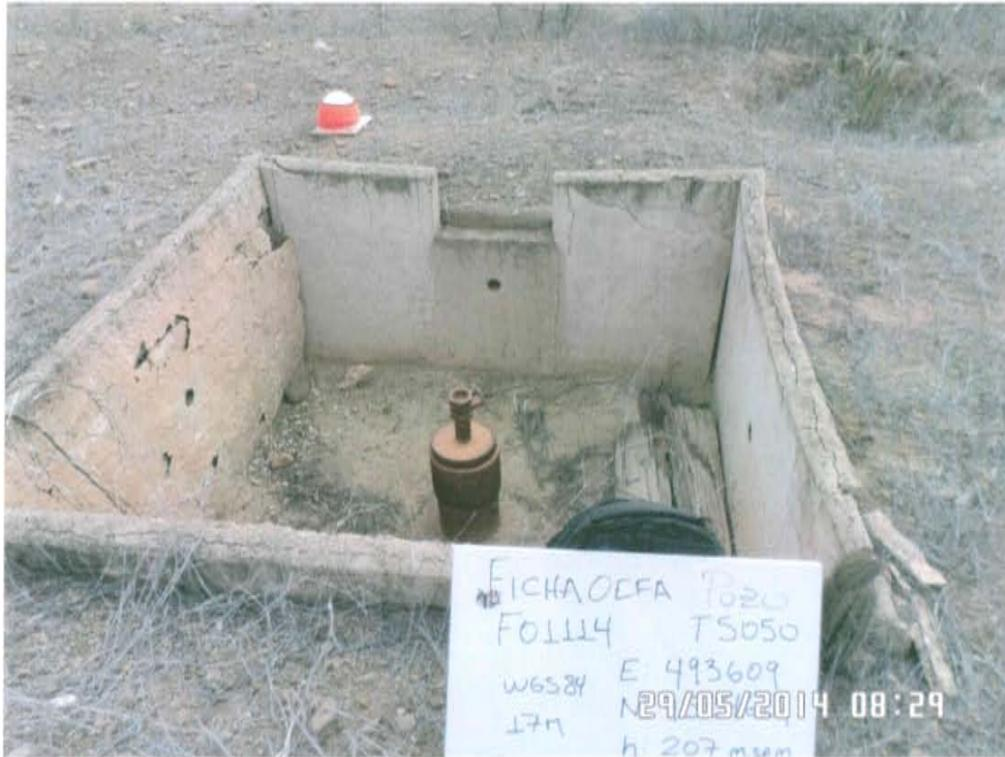
**Fotografía N° 1.** Vista del pozo inactivo con código de ficha OEFA F01114 (pozo T5050), se observa el casing dentro de una cantina desgastada
