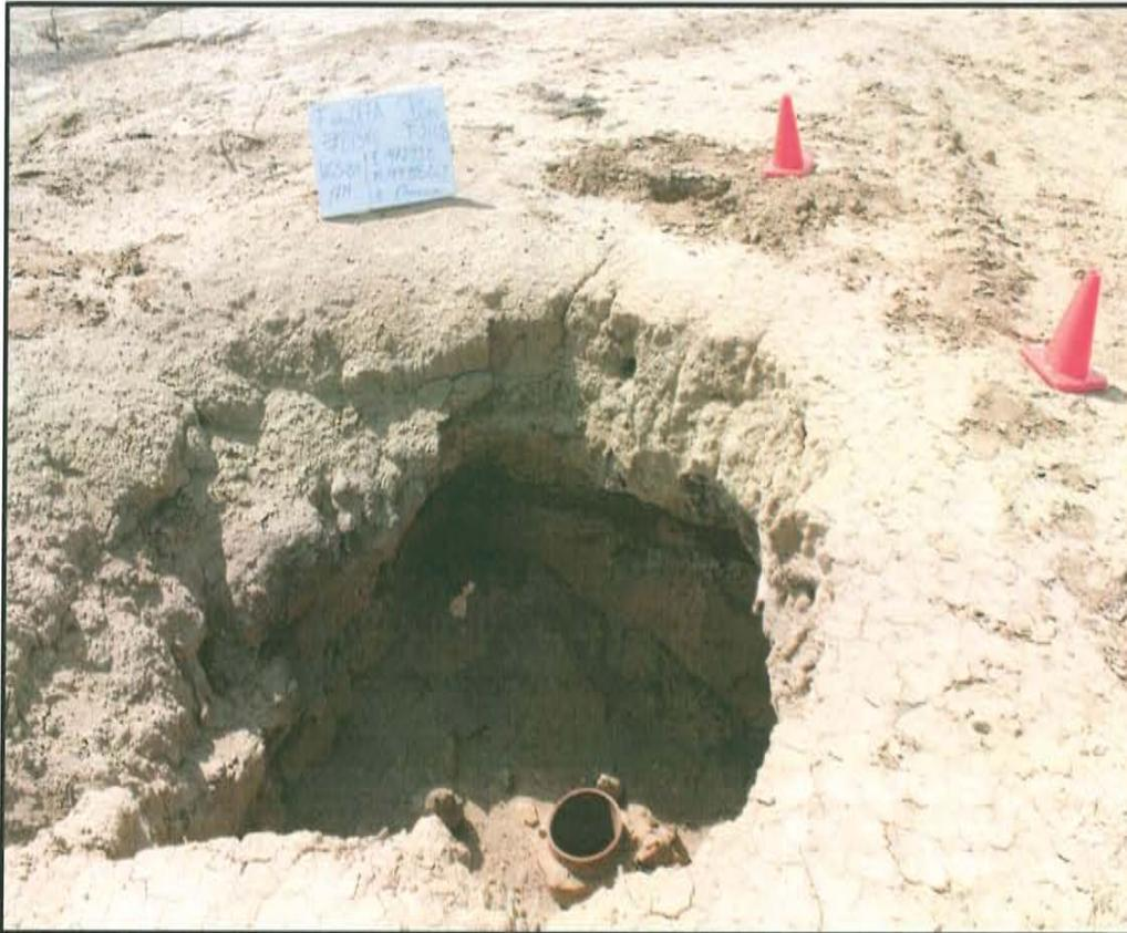
Fotografía N° 1. Pozo T 2108 presenta casing de 11 plg de diámetro y 0,2 m de la altura que sobresale desde la base del hoyo de 4 m de diámetro y 2 m de profundidad.
