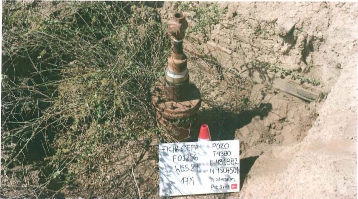
Fotografía N° 1. Se observa casing con brida en el interior de un hoyo, rodeado por vegetación autóctona.
