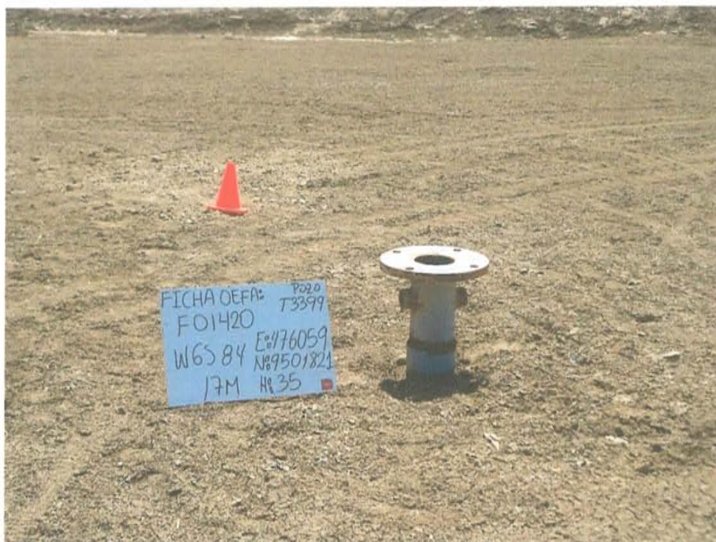
Fotografía N° 1. Pozo inactivo se puede observar cabezal de pozo con brida expuesta de aproximadamente 0.5 sobre el nivel del suelo.
