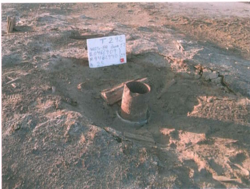
Fotografía N° 1. Identificación del pozo inactivo con código PERUPETRO T_292. Presenta casing sin válvulas que aseguren su hermetismo.
