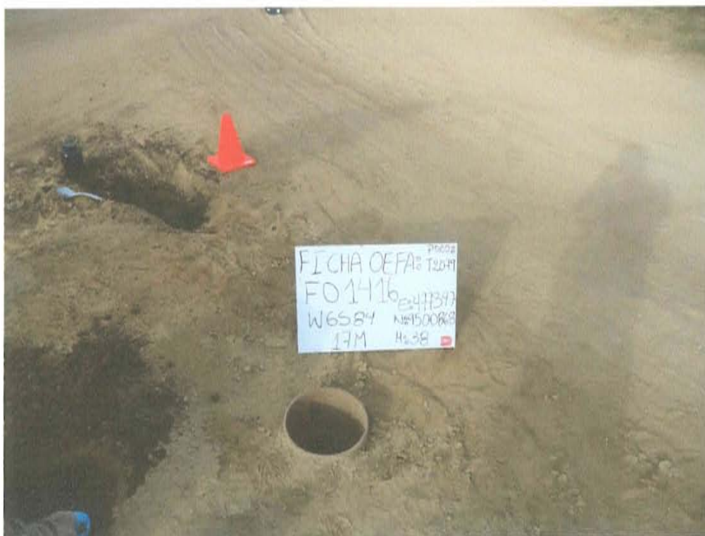
Fotografía N° 1. Pozo inactivo con código PERUPETRO T2079, se observa tubería a nivel del suelo (casing de revestimiento), aproximadamente 7 pulgada de diámetro.
