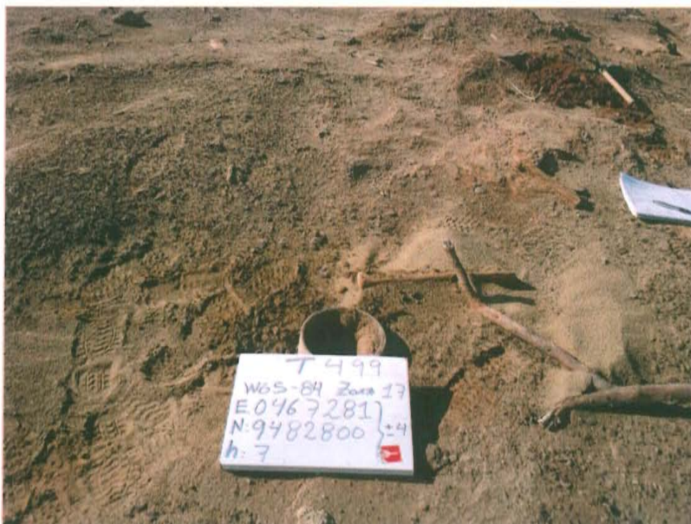
Fotografía N° 1. Identificación del pozo inactivo con código PERUPETRO T_499. Presenta casing sin válvulas que aseguren su hermetismo.
