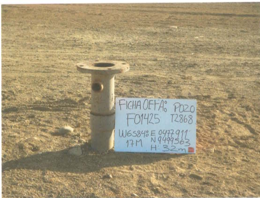
Fotografía N° 1. Pozo inactivo con cabezal de pozo y brida expuesta.
