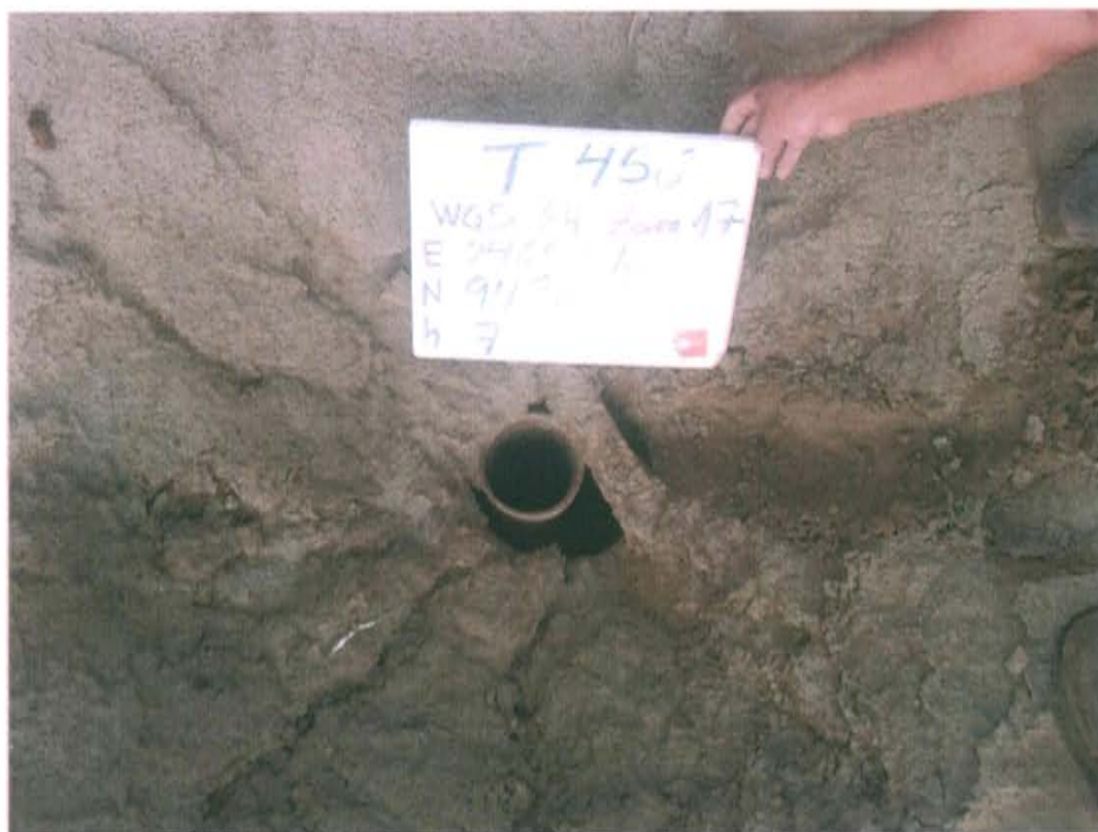
Fotografía N° 1. Identificación del pozo inactivo con código PERUPETRO T_456. Presenta casing sin válvulas que aseguren su hermetismo.
