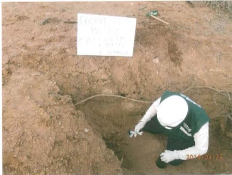
Fotografía N° 3. Toma de muestra de suelo en el punto F00841-SU01 a 0,8 m del pozo y a una profundidad de 0,6 m.
