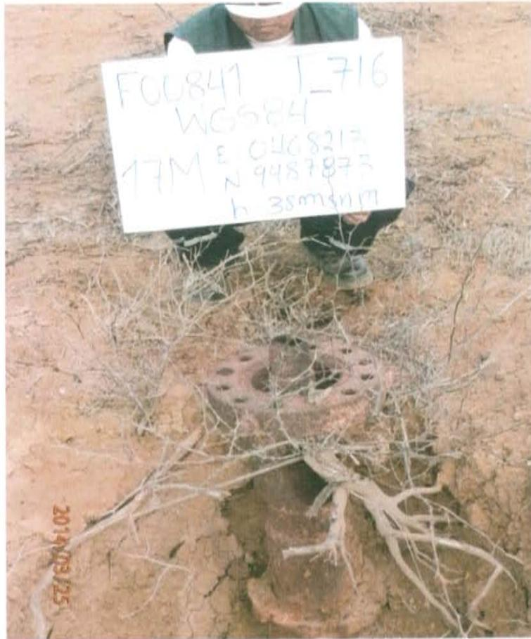
Fotografía N° 1. Pozo inactivo sin cabezal con el casing y brida.
