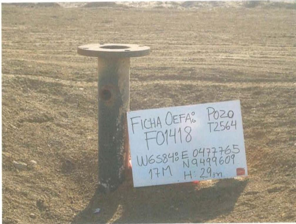
Fotografía N° 1. Pozo inactivo, se observa cabezal de pozo con brida expuesta de aproximadamente 0.55 m sobre el nivel del suelo.
