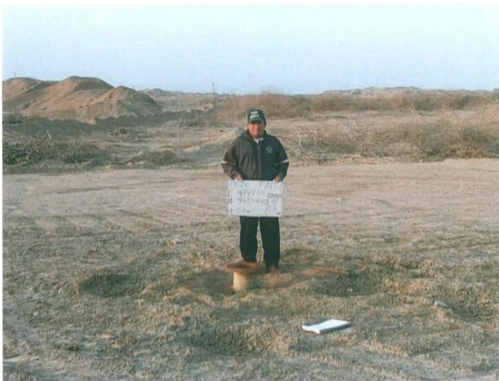
Fotografía N° 1. Identificación del pozo inactivo con código PERUPETRO T1491. Presenta casing sin válvulas que aseguren su hermetismo.
