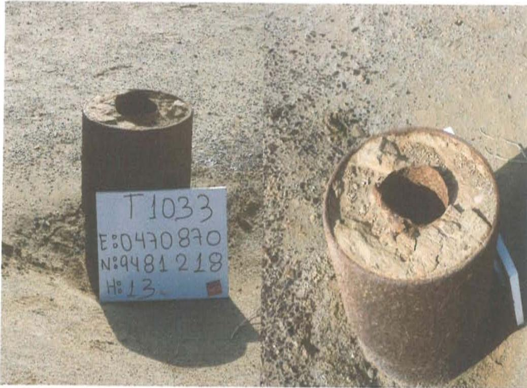
Fotografía N° 1. Identificación del pozo inactivo con código PERUPETRO T1033. Se observa casing de producción y superficie con cenmento entre ambos y abierto.
