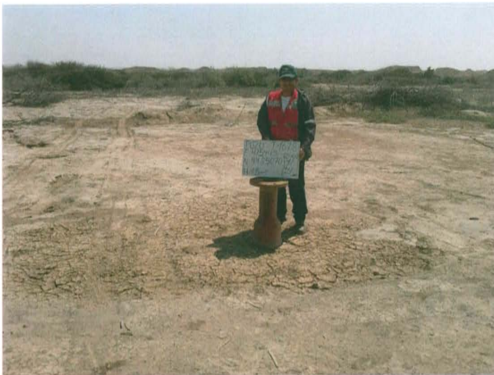
Fotografía N° 1. Identificación del pozo inactivo con código PERUPETRO T1678. Presenta casing sin válvulas que aseguren su hermetismo.
