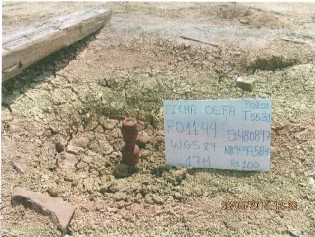
Fotografía N° 1. Se observa una tubería de reducción de 2 plg con válvula de cierre con claros signos de corrosión que posiblemente no garantice un cierre hermético y sobresale 0,25 m sobre el nivel de suelo.
