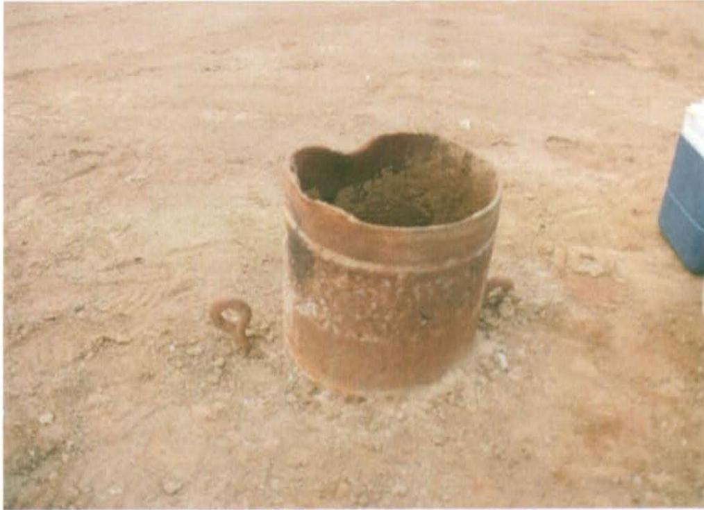
Fotografía N° 1. Pozo L\_378 presenta casing corroído con diámetro de apertura de 15 pulgadas, sin elementos de cierre.
