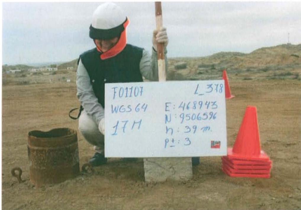
Fotografía N° 2. casing dañado y como señal preventiva se ha instalado un poste de madera
