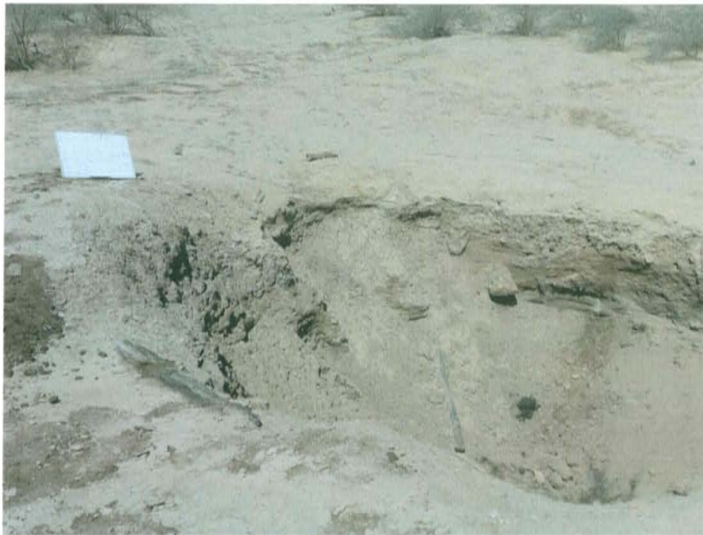
Fotografía N° 1. Identificación del pozo inactivo con código PERUPETRO T2446, presenta casing sin válvulas que aseguren su hermetismo.
