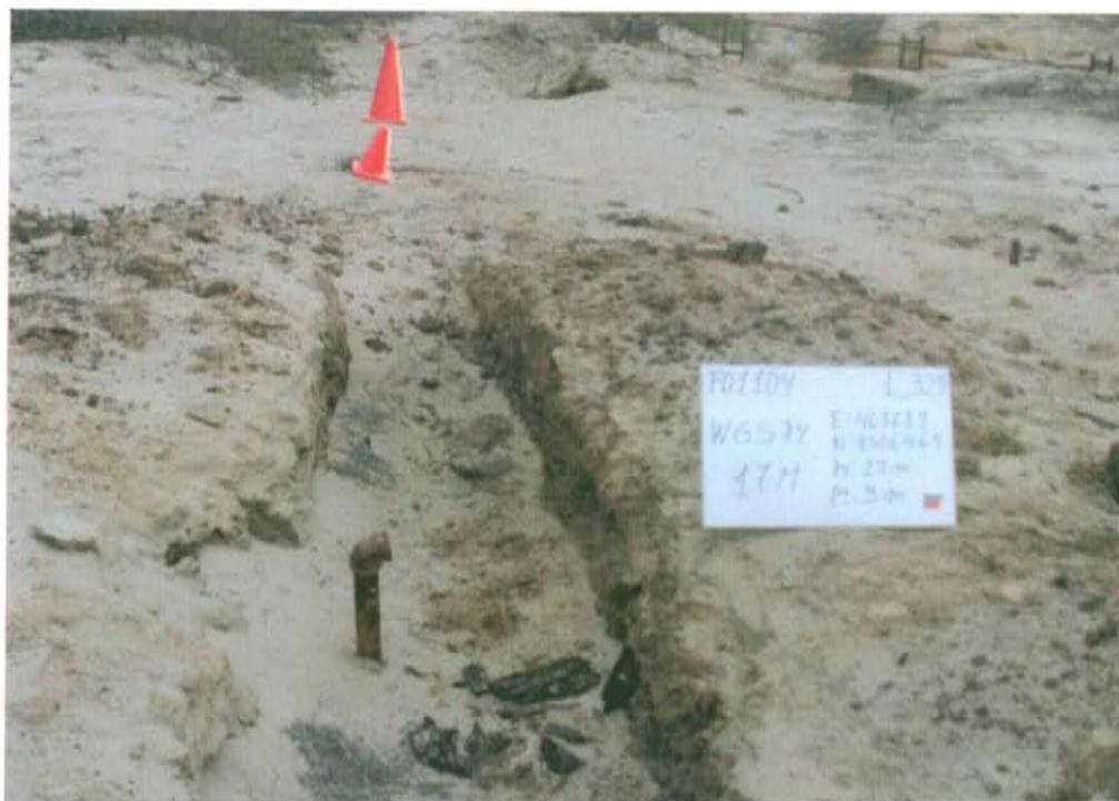
Fotografía N° 1. Pozo L\_329 presenta una casing corroído, abierto y sin elementos de cierre, dentro de restos de posible cantina de 30cm de profundidad.
