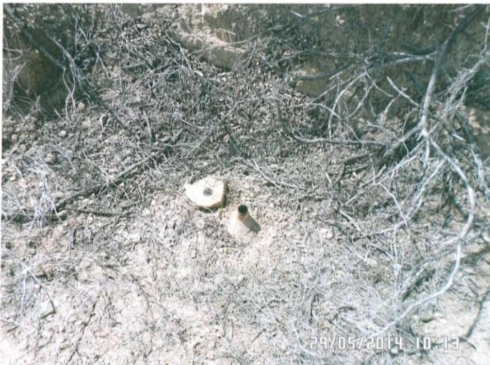
**Fotografía N° 2.** Vista del pozo con código de ficha OEFA F01117 (pozo T4580), se observa una reducción tipo botella expuesta de 2 plg de diámetro y 0,15 m desde la superficie del suelo
