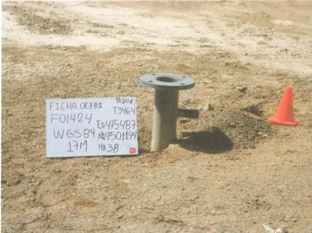
Fotografía N° 1. Pozo inactivo con código PERUPETRO T3464, con cabezal de pozo y brida expuesta.
