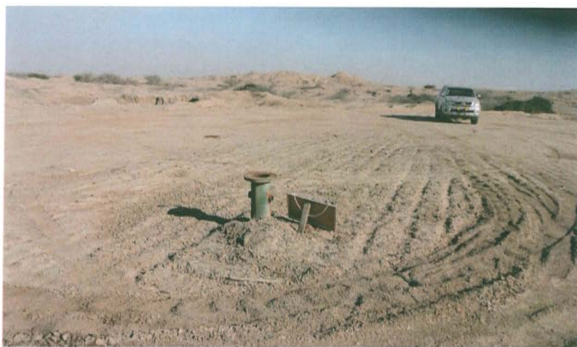
Fotografía N° 2. Se observa acceso vehicular hasta el mismo Pozo T2707.
