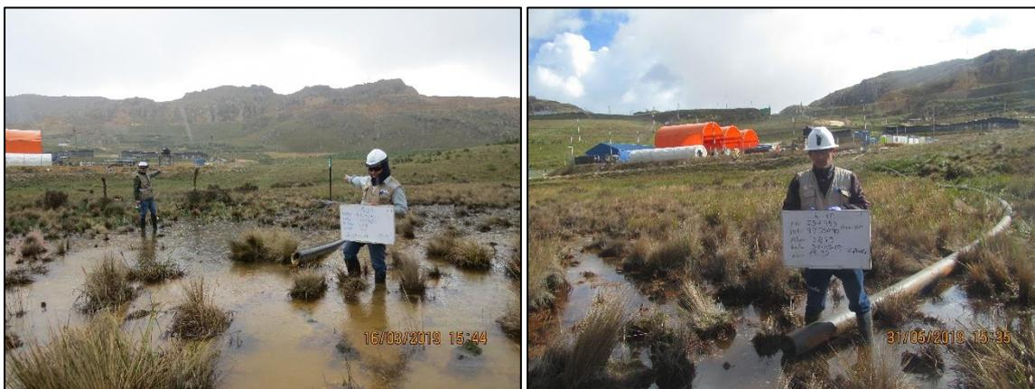
Figura 8.37. Tubería del efluente E-1A sin flujo, ubicado en la laguna Los Gentiles 4 (A-8)
