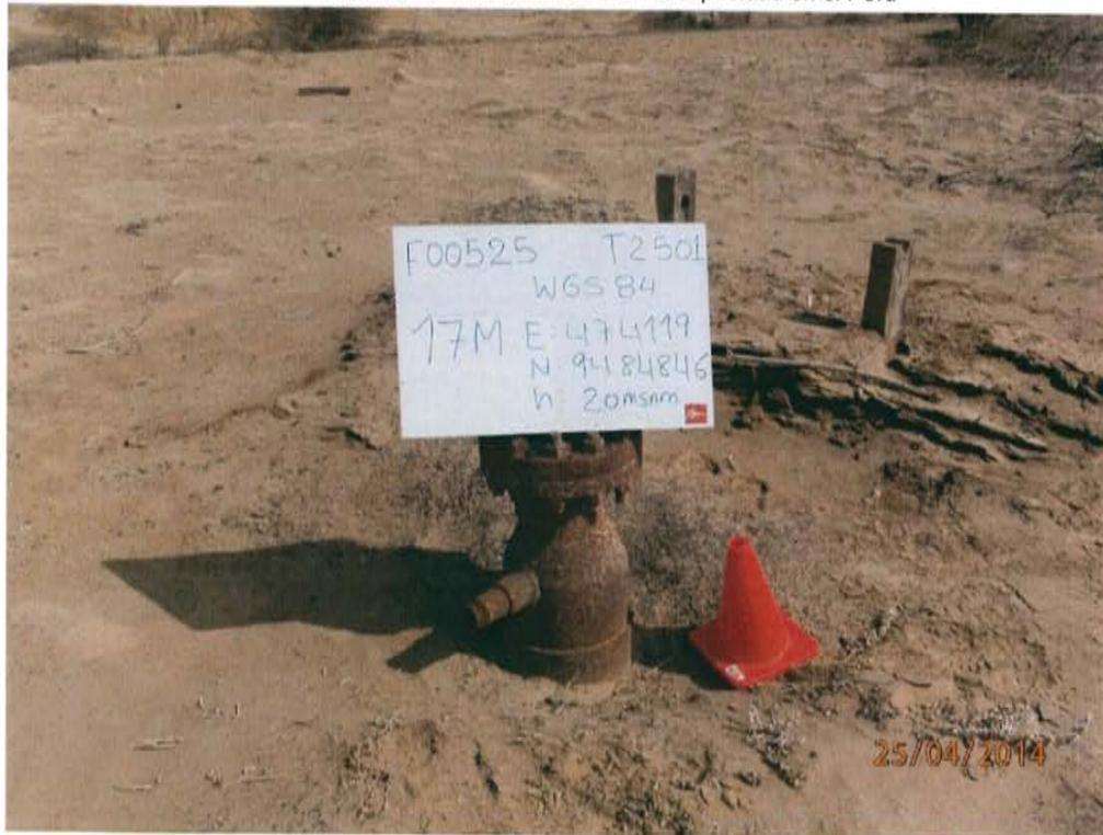
Fotografía N°3. Pozo inactivo T2501, sin válvulas que aseguren su hermetismo.
