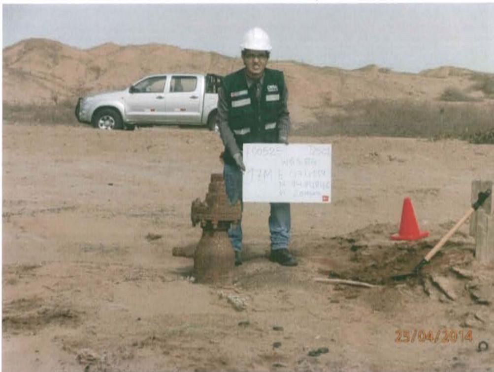
Fotografía N° 1. Identificación pozo inactivo con código PERUPETRO T2501. Presenta casing con cabezal sin válvula de cierre.
