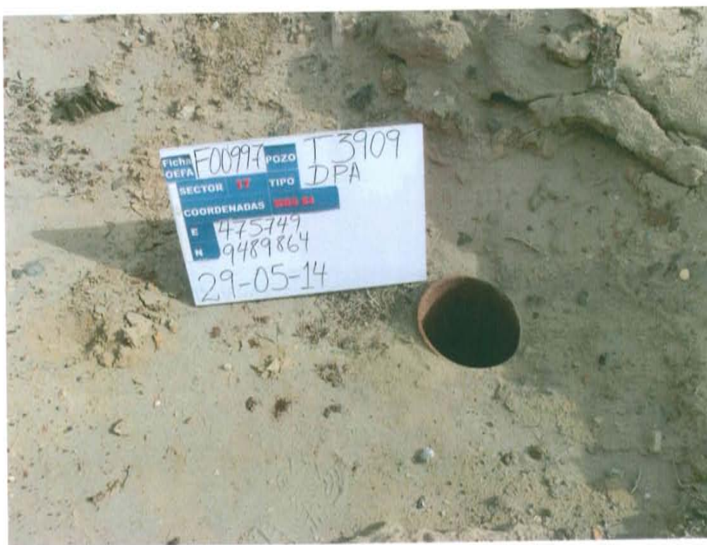
Fotografía N° 1. Se observa el casing descubierto a nivel de superficie correspondiente al pozo inactivo con código PERUPETRO T3909.
