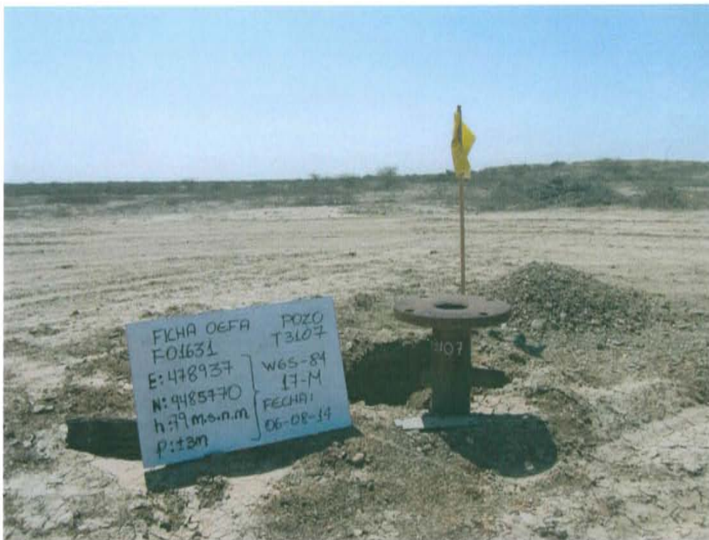
Fotografía N° 1. Pozo inactivo con código PERUPETRO T3107. Se observa casing a nivel de superficie
