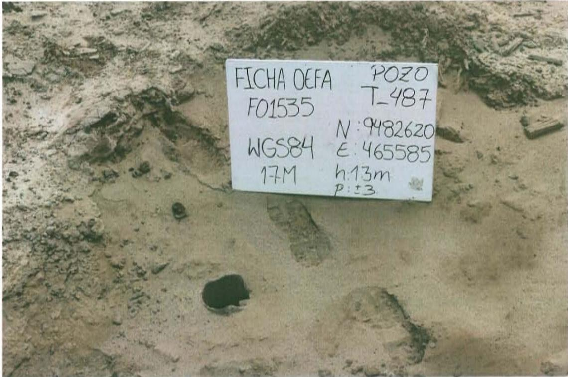
Fotografía N° 1. Identificación del pozo inactivo con código PERUPETRO T\_487. Presenta casing corroído y cortado descubierto en una excavación.
