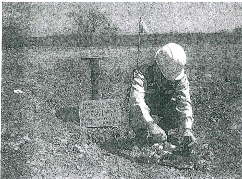
Fotografía N° 1. Toma de muestra de suelo en el punto F01635-SU01, ubicado a 0,9 m aproximadamente del Pozo T3091.
