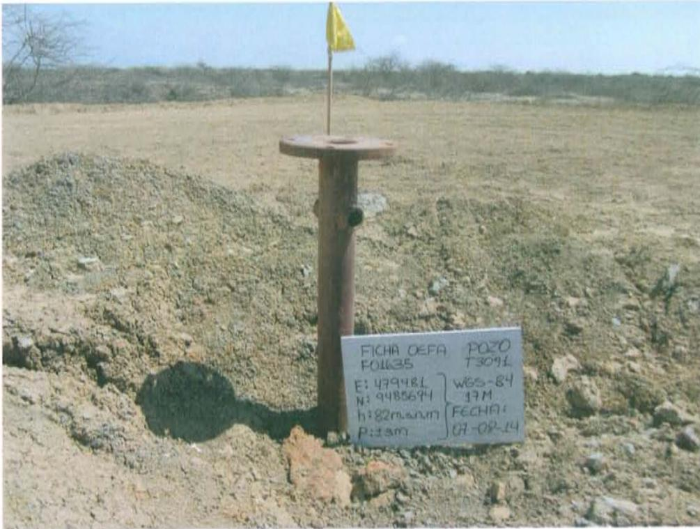
Fotografía N° 1. Pozo inactivo con código PERUPETRO T3091. Se observa casing a una altura aproximada de 1 m sobre la superficie del suelo.
