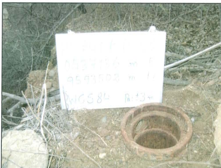
Fotografía N° 1. Pozo inactivo, con casing semienterrado abierto al ambiente de 6 plg de diámetro y al filo del barranco.
