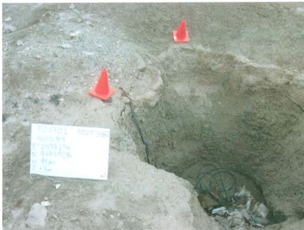
Fotografía N° 1. Identificación del pozo inactivo con código PERUPETRO T3380. Presenta casing sin válvula que no aseguraba su hermetismo.
