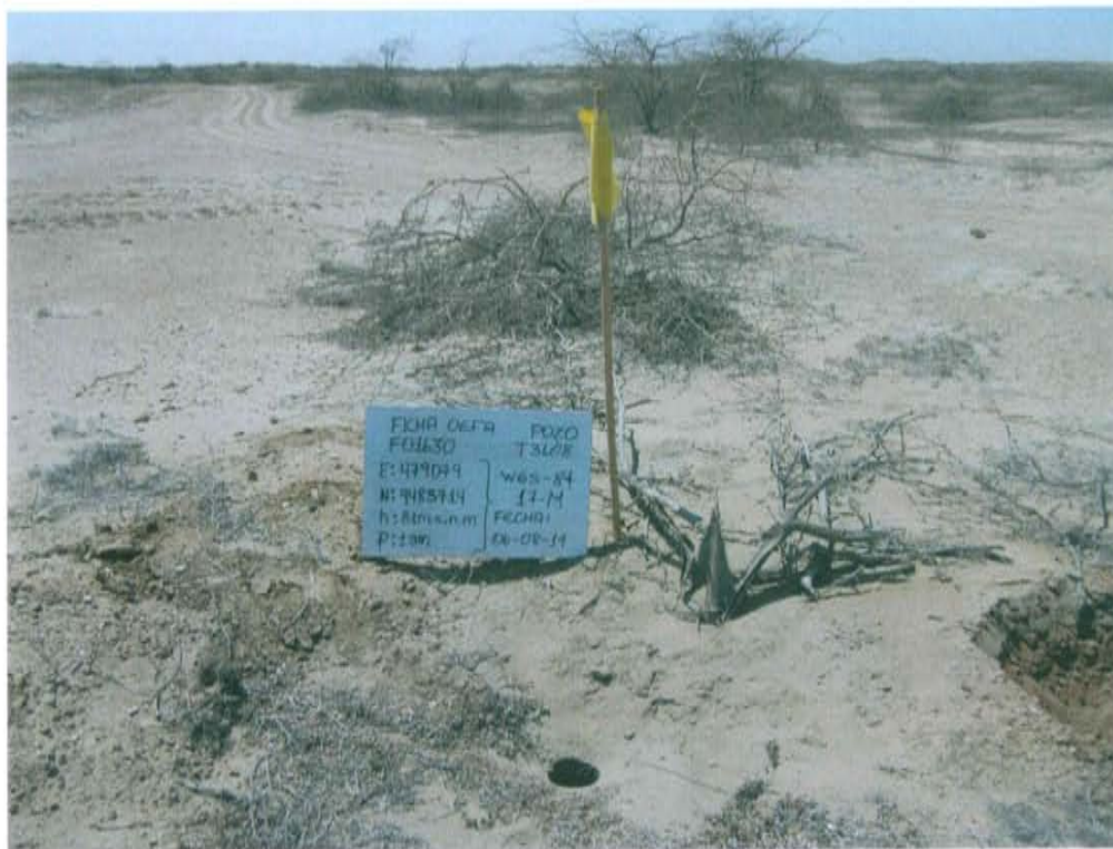
Fotografía N° 1. Pozo inactivo con código PERUPETRO T3108. Se observa casing a nivel de superficie
