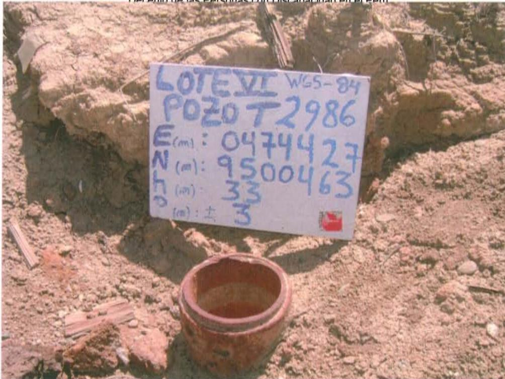
Fotografía N° 1. Identificación del pozo inactivo con código PERUPETRO T2986. Presenta casing sin tapón y se encuentra expuesto al ambiente.
