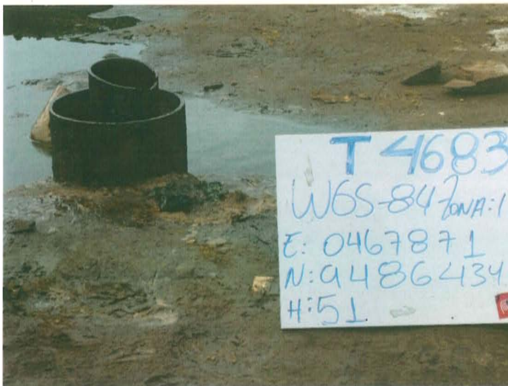
Fotografía N° 1. Pozo con código PERUPETRO T4683 inactivo mal abandonado sin cabezal con casing y tubo interior corroído.
