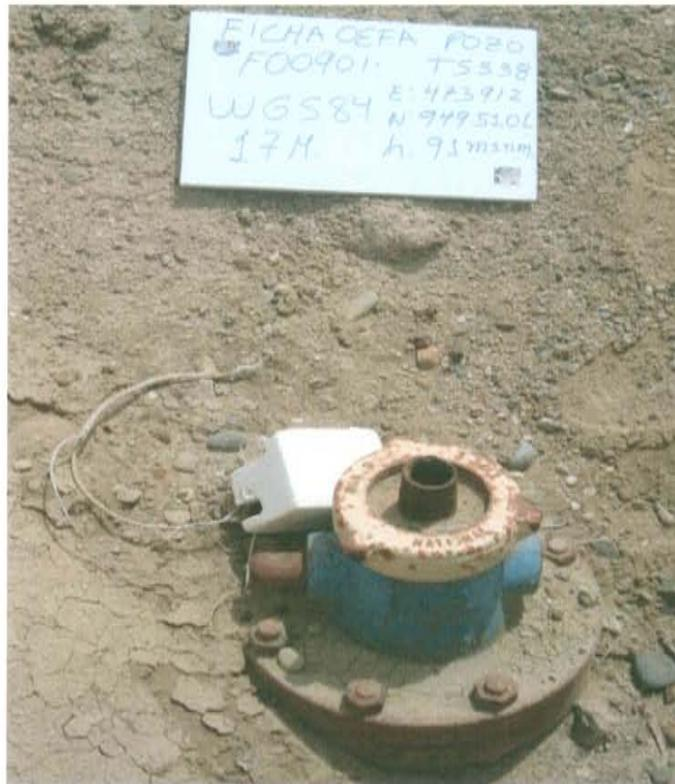
Fotografía N° 01.- Pozo con código PERUPETRO T5338 y con código Ficha OEFA F00901, con el casing enterrado, se observa la brida reductora tipo E con una tubería corroída y abierta y sin válvulas que aseguren su hermetismo.
