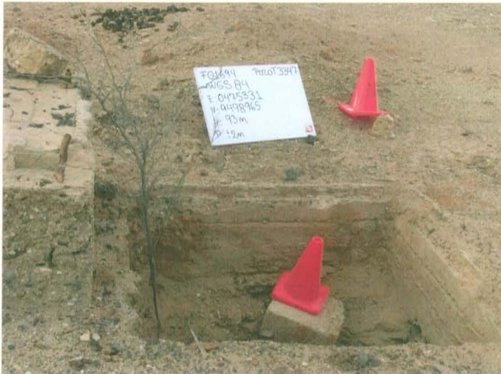
Fotografía N° 1. Identificación del pozo inactivo con código PERUPETRO T3347. Presenta casing sin válvulas que aseguren su hermetismo.
