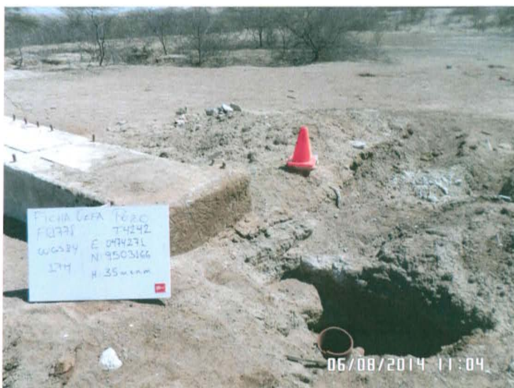
Fotografía N° 2. Vista panorámica del pozo T4242, se observa suelo impregnado con hidrocarburos en el área circundante al pozo.
