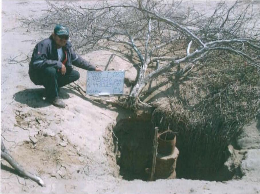
Fotografía N° 1. Se aprecia casing corroído ubicado dentro de una excavación abierto y sin elementos de cierre.
