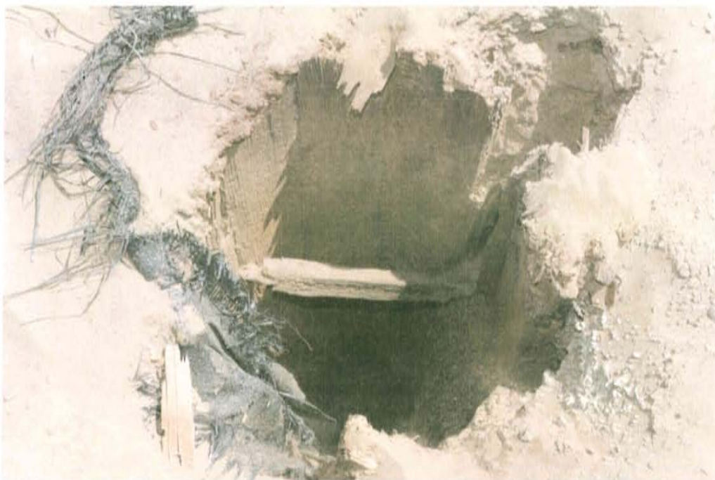
Fotografía N° 2. Se observa Pozo que presenta una conductora de madera, expuesto al ambiente, sin elementos de cierre en superficie.
