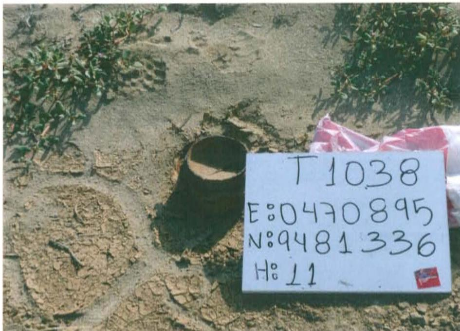
Fotografía N° 1. Pozo T1038 se observa un casing corroído abierto y expuesto 0,35 m en relación al suelo, sin elementos de cierre que garanticen su hermeticidad. En su interior se observa arena.
