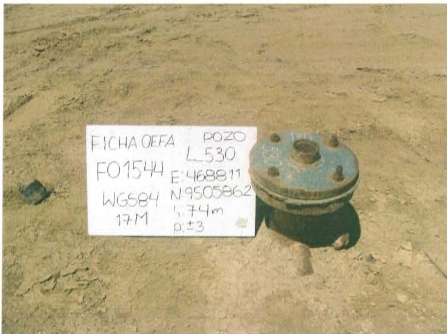
Fotografía N° 2. Se observa casing con brida unidad que presenta un reducción en la parte superior encontrándose abierta sin elementos de cierre (válvulas, llaves entre otros).
